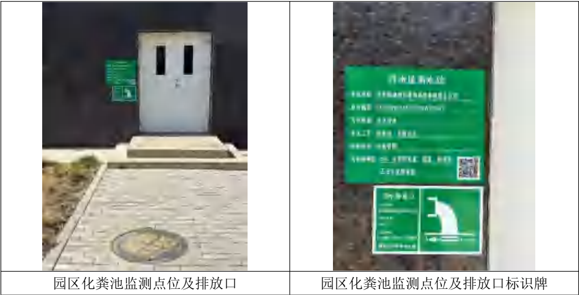
图 4.3-1 废水监测点位及排放口标识牌
